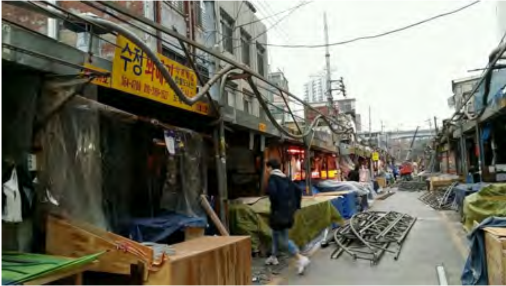
▲ 2016 영천시장 리모델링 사업 공사현장
